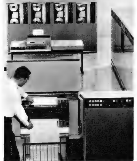
Siemens 4004, eine neue Datenverarbeitungsanlage mit integrierten Schaltungen. Links vorn der Schnelldrucker
