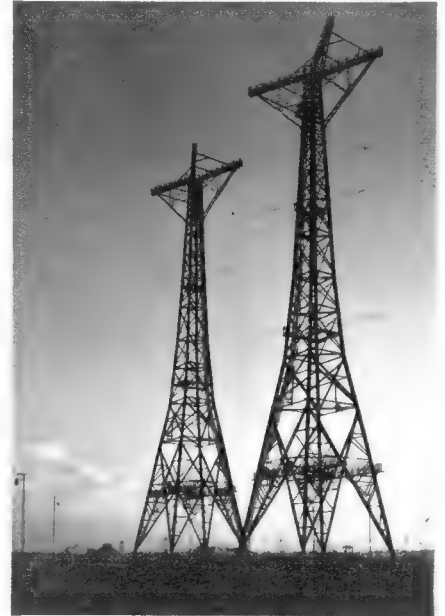
Bild 1. Die alte Drehstandantenne mit zwei Holzmasten für den Kurzwellensender PCJ in Huizen. Beide Masten standen auf einem großen Kreis aus Eisenbahnschienen. Sie wurde vor fünf Jahren abgebaut
